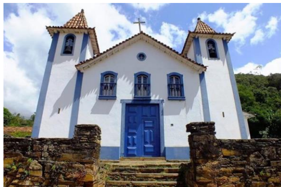
São Bartolomeu - MG
