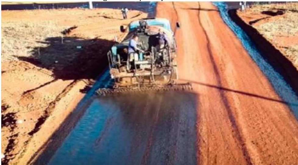
Figura 4: Imprimação de base
