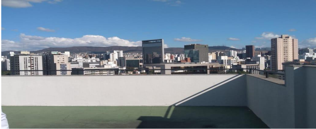
Figura 24 - Muro do terraço
